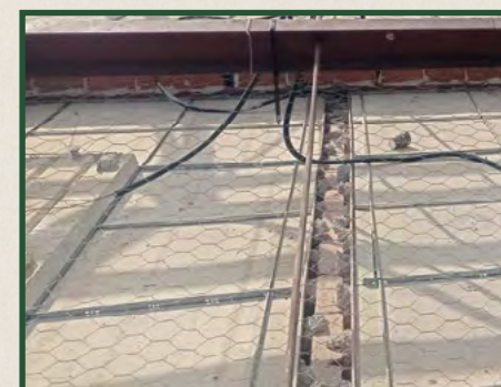
Renovación de tejado del Salón de Actos, cambio de ventanas y puerta de entrada 80.000 con subvención de Diputación de 60.000 €.
