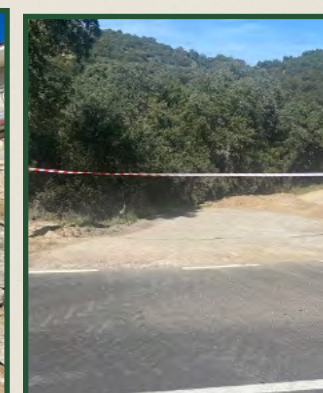
Inversiones en arreglo de caminos y redes de agua para el sector primario 12.000 €.
